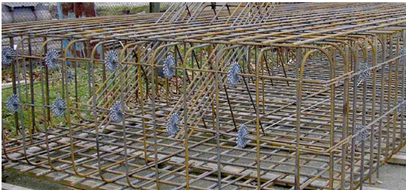
Svetsning av armering kräver behörig personal, måttnoggrannhet och formstabilitet. Vi har de personella och maskinella resurser som krävs för all slags svetsning av armering.
